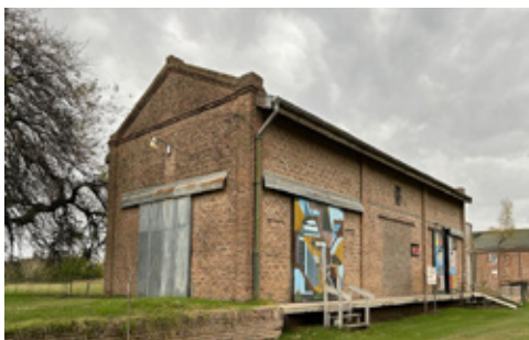
Galpón de cargas de la antigua estación ferroviaria de Las Marianas, hoy integrado al museo del ferrocarril en el partido de Navarro.
