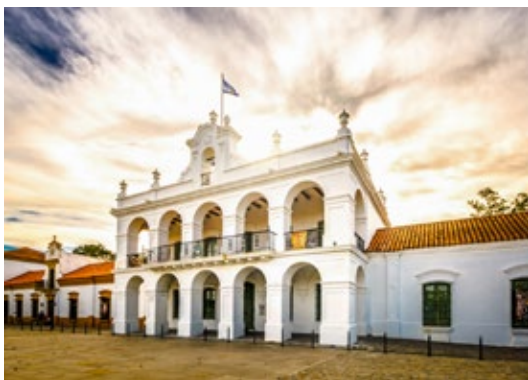
El Cabildo de Luján, uno de los edificios que integra el recorrido.
